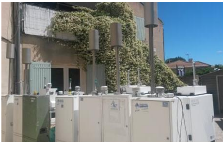
Figure 4 : Vue des dispositifs de prélèvement (6 Partisol + 6 DA80) déployés sur site.
