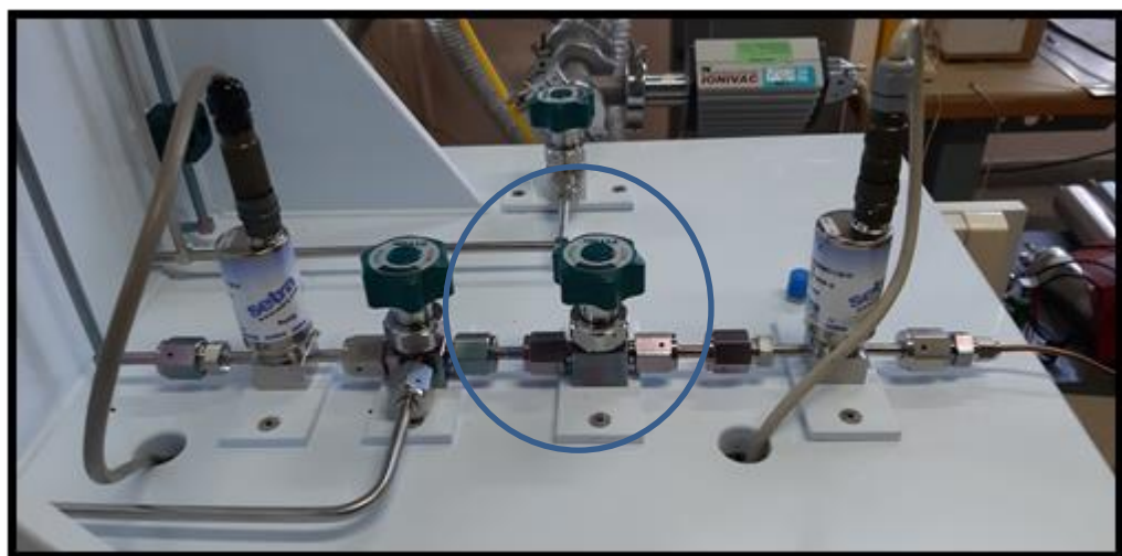
Figure 6 : Partie aval de la rampe-vanne de régulation
