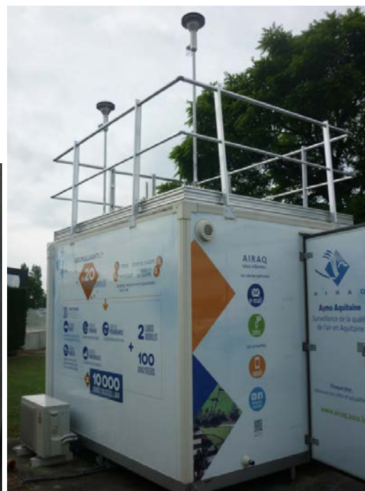
Figure 2 : toit de la station de mesure
