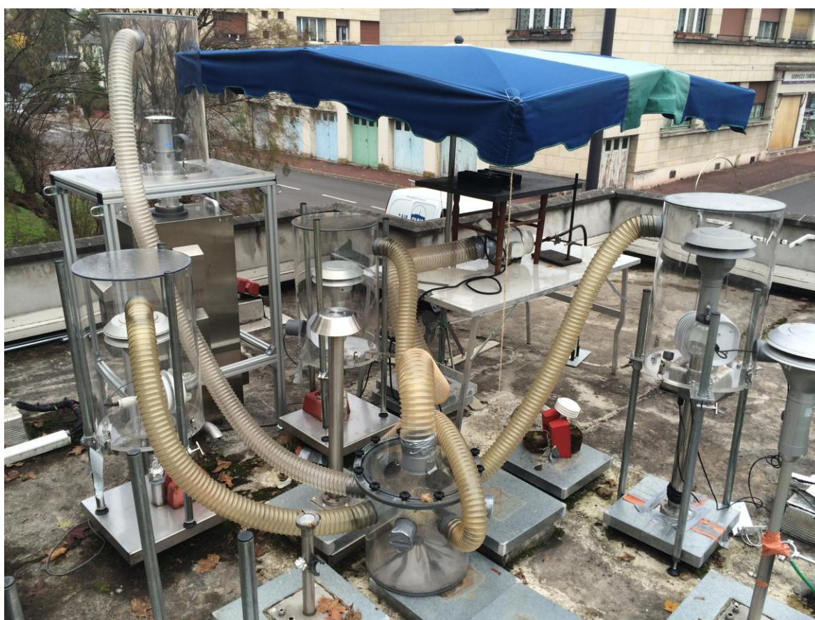
Figure 1 : Deux BAM 1020, un MP101M+ ainsi qu'un préleveur Leckel, tous connectés au dispositif de dopage sur le toit de la station de «La faïencerie Creil, AtmoPicardie »
