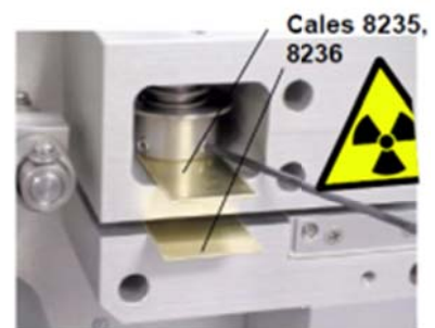
Remontage à l'aide de cales
